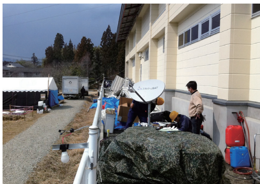
仮設住宅の集会所にアンテナを設置する様子。左が小型地球局（VSAT）。
