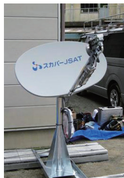
仮設住宅の集会所にアンテナを設置する様子。左が小型地球局（VSAT）。
