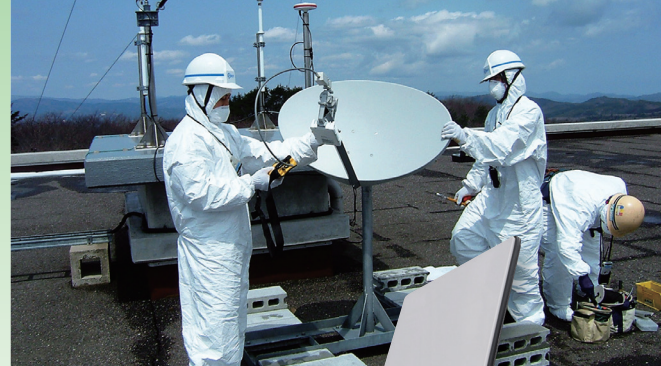
被災地で衛星通信のアンテナを設置する様子。
